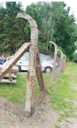
▲ Ursprungligen bar dessa betongpelare upp en dubbel taggtråd, genom den yttre taggträden gick det en spänning på 360 volt.
